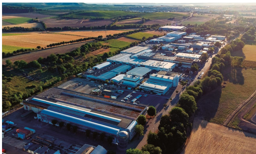
Vista de la fábrica de bomba de calor de Daikin en Alemania.
