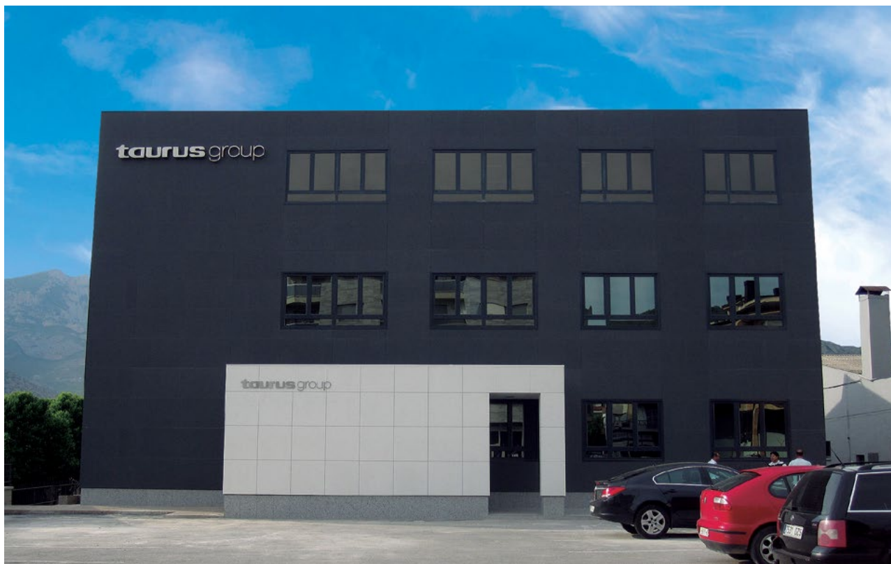
Instalaciones de Taurus en Oliana.
